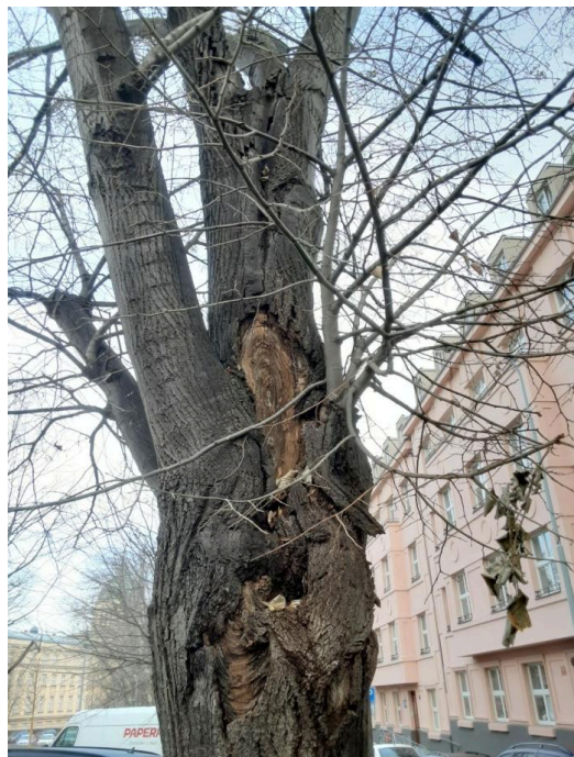
Obrázek 2 – poškození na bázi koruny
