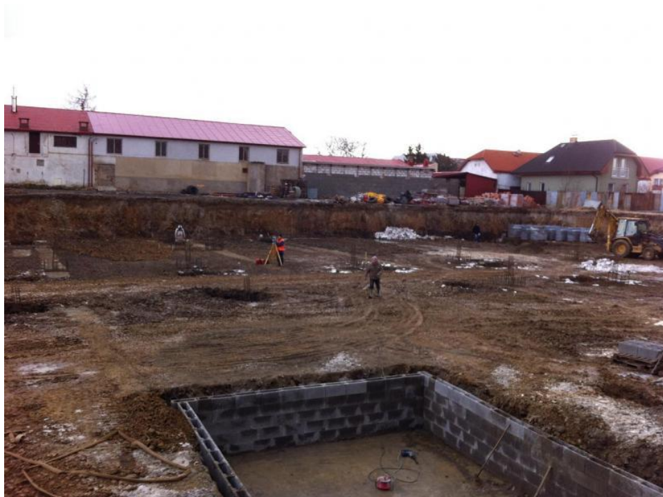
Obrázek 1: Období výstavby 16 ŘRD_CITADELA 16, zakládání v nepažené jámě (rok 2011)
