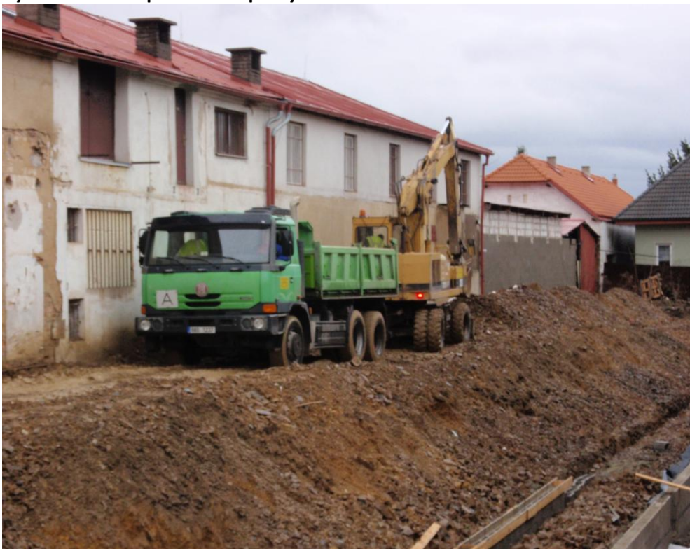
Obrázek 4: Výstavba teras pomocí těžké mechanizace (02/2013)
