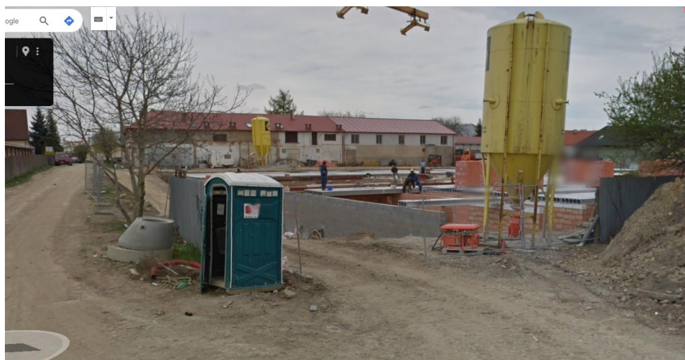
Obrázek 2: Výstavba stropu v 1. NP v komplexu 16 ŘRD_CITADELA 16 (04/2012)
