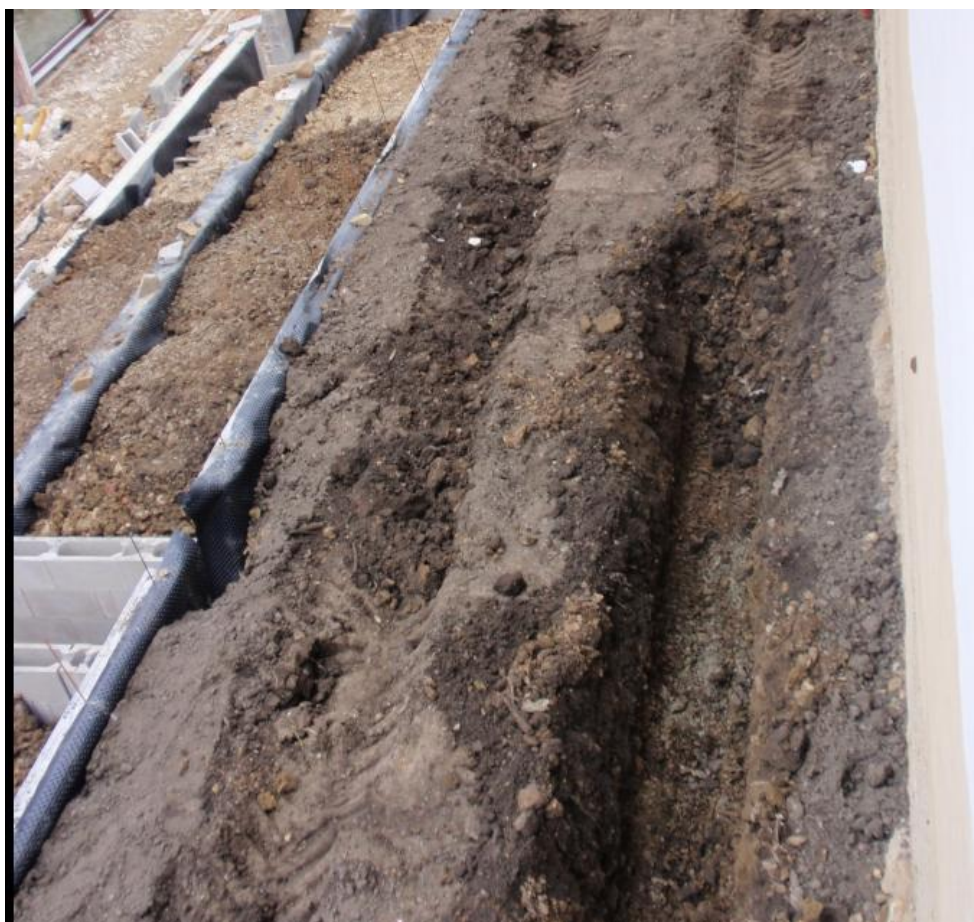
Obrázek 6: Stav u základové spáry objektu č.p. 115/213 v dubnu 2013
