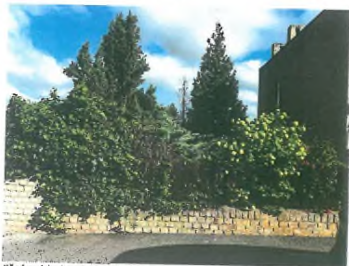
Jižní pohled z ulice, 4/2024
